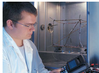
Mapowanie szaf klimatyzowanych
